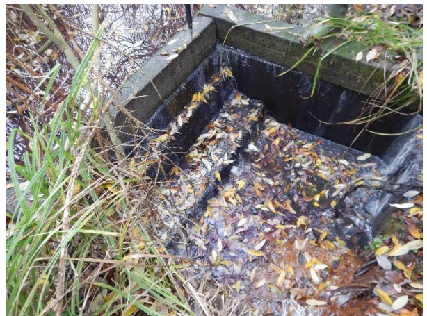
Abbildung 1-7: Ablaufbauwerk Regenrückhalteteich mit aufgelagerten Zaunpfählen
