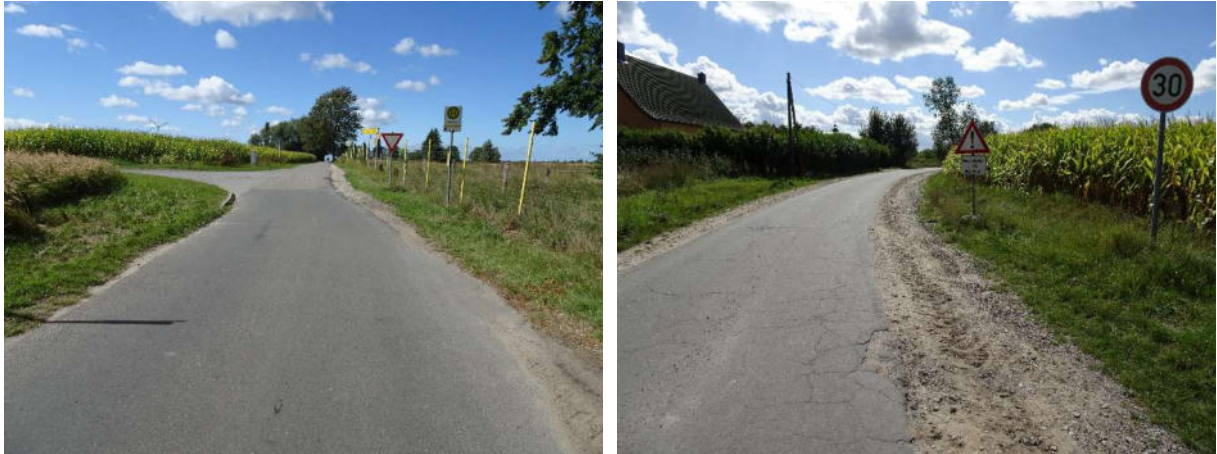
Abbildung 1: Knoten Bauanfang mit ausgefahrenen Banketten
