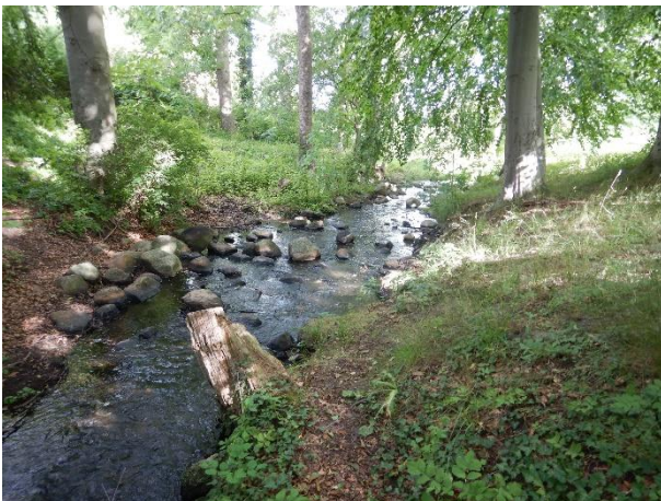
Abbildung 4-6: Umfluter bei km 0+045, Blick in Fließrichtung, unregelmäßig gelagerte Steine
