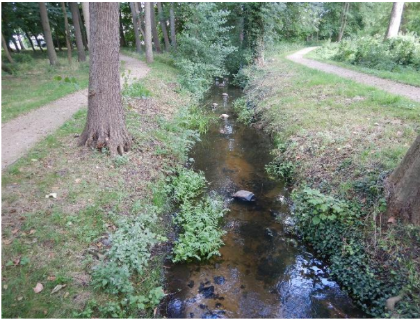
Abbildung 4-2: Umfluter bei km 0+190, Blick in Fließrichtung
