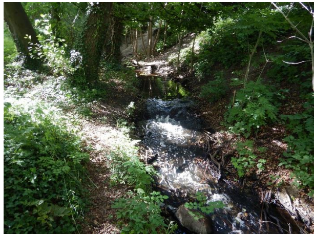
Abbildung 4-5: Umfluter bei km 0+058, Blick gegen Fließrichtung, Sohlabstürzt durch Baumwurzel
