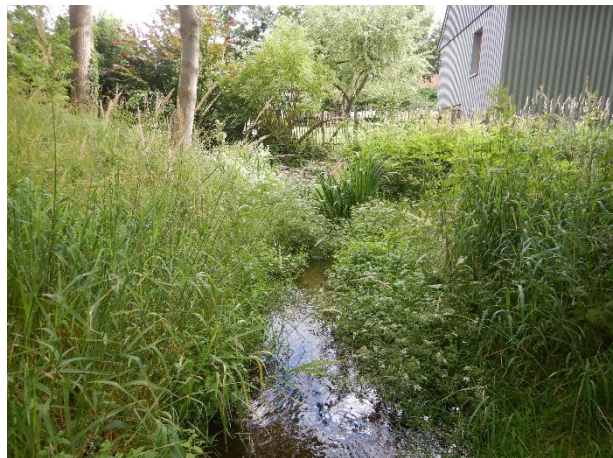
Abbildung 4-7: Umfluter bei km 0+005, Blick in Fließrichtung, vor der Einmündung
