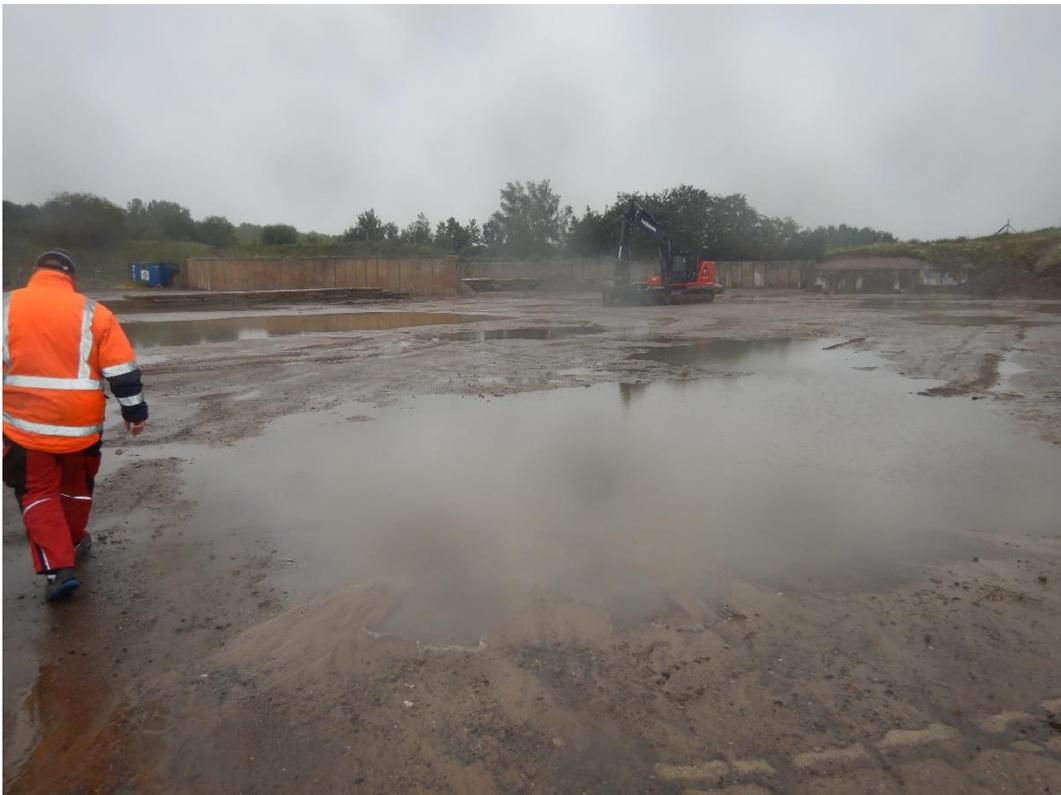
**Abbildung 1-1:** Die Situation auf dem Grundstück der Hagemann GmbH in Broderstorf während eines Regenerignisses am 10.07.2020 verdeutlicht, dass das bestehende Entwässerungssystem nicht mehr funktionsfähig ist.
