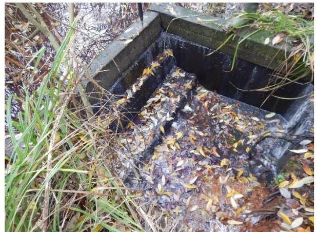
**Abbildung 1-7: Ablaufbauwerk Regenrückhalteteich mit aufgelagerten Zaunpfählen**
