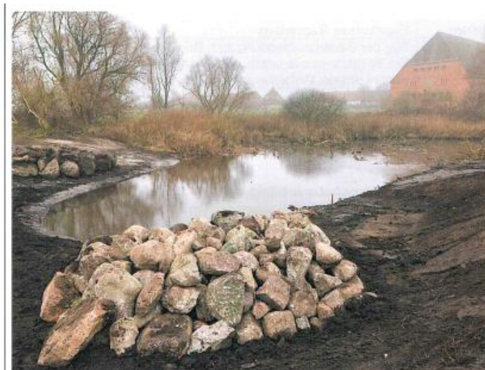
Erweiterungsfläche mit Lesesteinhau'n nach Fertigstellung
