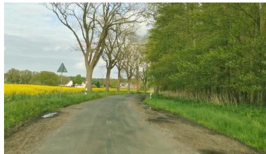
Am Bauende vor Einbindung auf die Landesstraße
