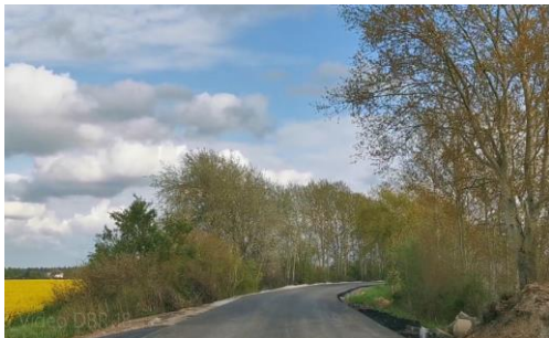
Blick in Richtung Bauende
