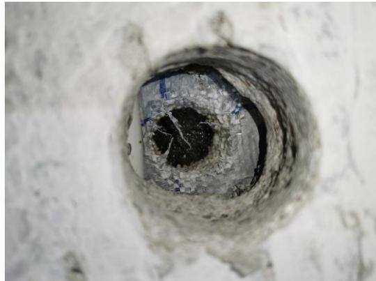
Schimmelwachstum an der Wand der Umkleidekabine, in der Fußbodenkonstruktion stand teilweise Wasser.
