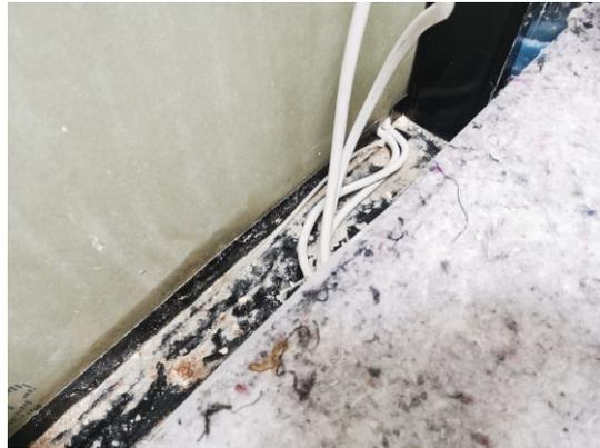
Offene Trockenbauwände in den Umkleiden mit erkennbarer Schimmelbelastung
