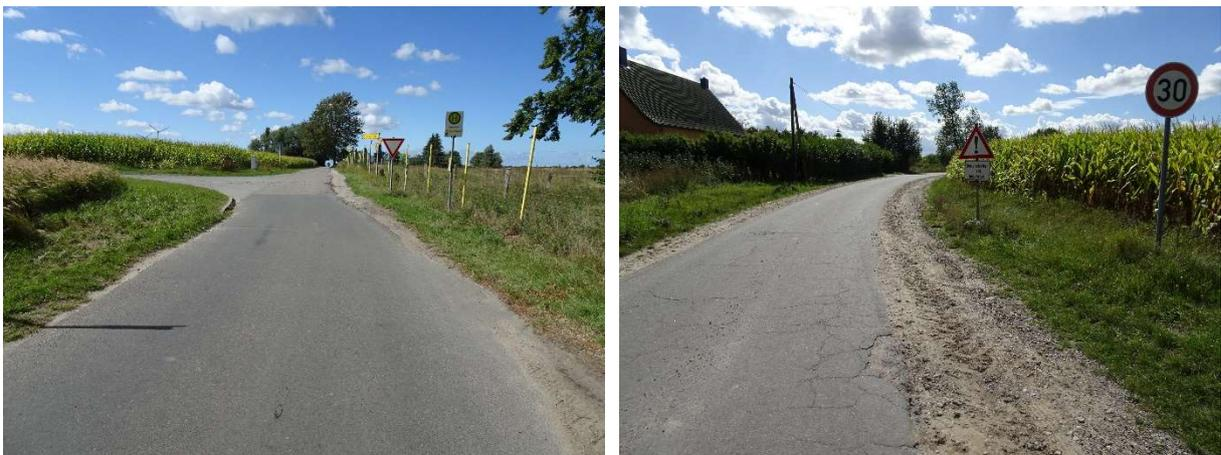
Abbildung 1: Knoten Bauanfang mit ausgefahrenen Banketten
